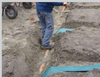
Die ausgehobenen Gräben werden mit einer 3-5 cm dicken Sandschicht aus gewaschenem Sand (Bausand/ Rheinsand/ Quarzsand) der Körnung 0-2 mm verfüllt.
